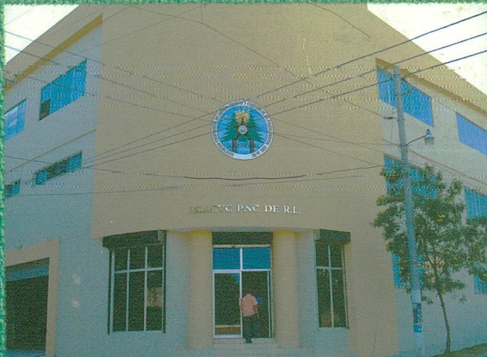
NUEVO EDIFICIO ACACYC PNC DE R.L.
